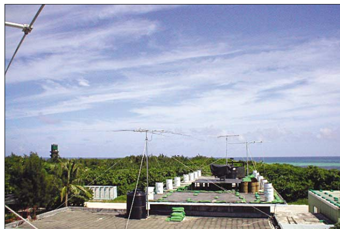
Auf dem Dach der Unterkunft fanden die drei Yagiantennen für die höherfrequenten Bänder einen guten Standort.
