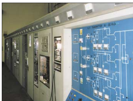
Bild 6: Die drei 16-kHz-VLF-Sender besitzen heute ein modernes Outfit und eine Luftkühlung. Fotos: G. Schenz
